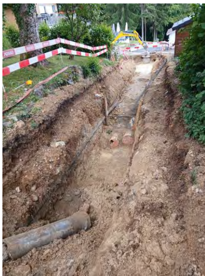
Pendant les travaux
